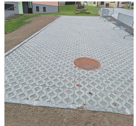
Parkplatz mit nicht versiegelter Fläche
