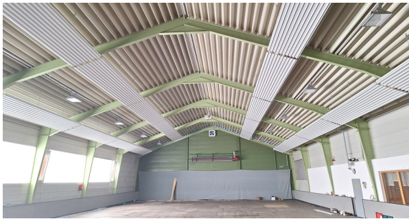
Raus aus dem Gas im Sport- und Kulturzentrum Neue Deckenheizung in der Tennishalle
